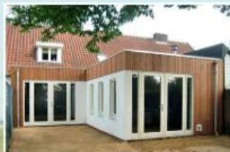
Nieuwbouw en verbouw
