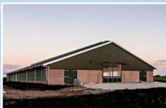
Ligboxstallen, loodsen en schuren
