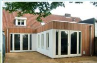
Nieuwbouw en verbouw
